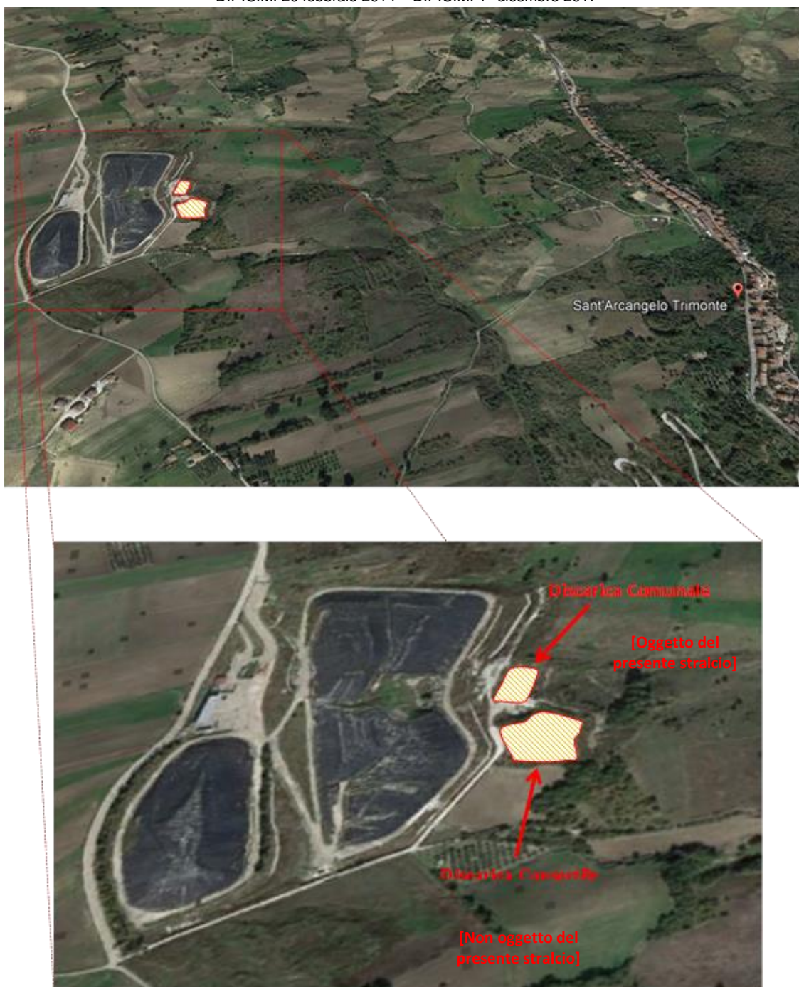
Figura 5.2 - Ripresa aerea dell'area delle discariche Comunale e Consortile
